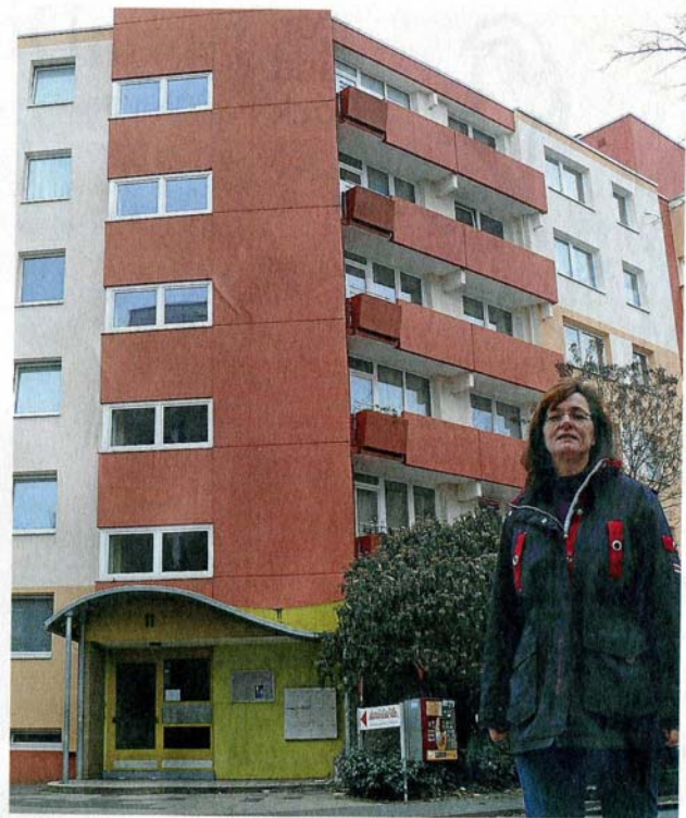
Heike Siemann setzt auf Wärmedämmung: Fast 1200 Quadratmeter Fassade wurde seit 2009 gedämmt, nächstes Jahr geht es weiter. Alte Fenster wurden ausgetauscht. Foto: kaj
