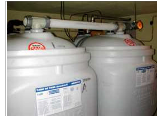
Oberirdische Batterietankanlage
