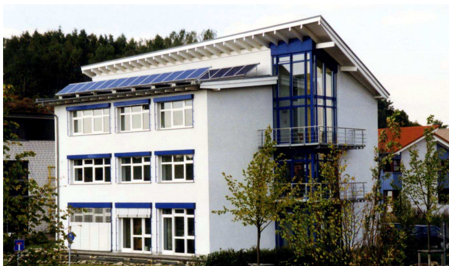
Photovoltaikanlage, Dienstleistungsgebäude; Gewerbepark Hamm
