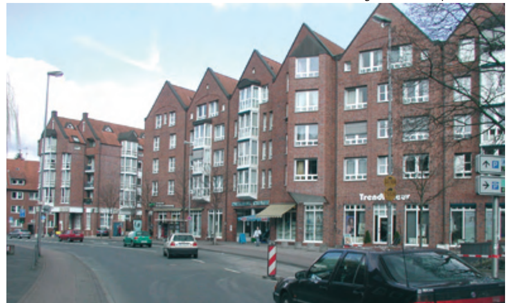
Ansicht Bebauung von An der Apostelkirche
