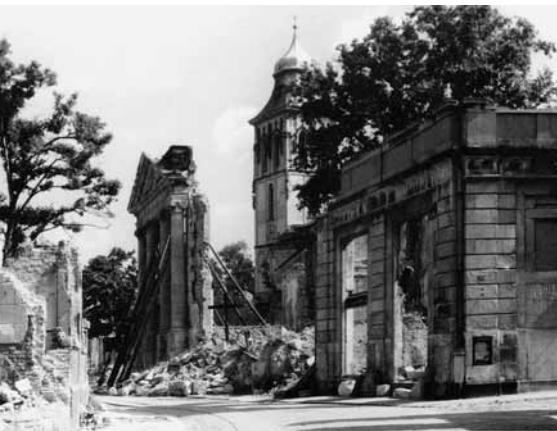
Die Ruine von Romberger Hof und Stadttheater an der Neubrückenstraße um 1945/1946, Foto: Stadtmuseum Münster
